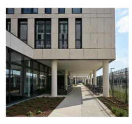
La masse moyenne d'un panneau de dimensions (ep x l x L) : 3 cm x 50 cm x 80 cm est de 27,6 kg, en effet la masse volumique moyenne de ces pierres est de l'ordre de 2300 kg/m³. Pour la mise en œuvre des blocs, un espace de 6 mm d'air a été ajouté entre les plaques. Les ratios surfaciques sont adoptés selon l'hypothèse d'un module standard duplicable, représentatif de l'unité fonctionnelle.
